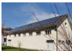
Trafostation Oberwiesen, 101m 2
