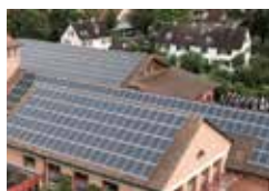
Thurplus, Gaswerkstrasse, 500m 2
