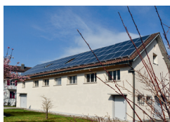
Trafostation Oberwiesen, 101m 2
